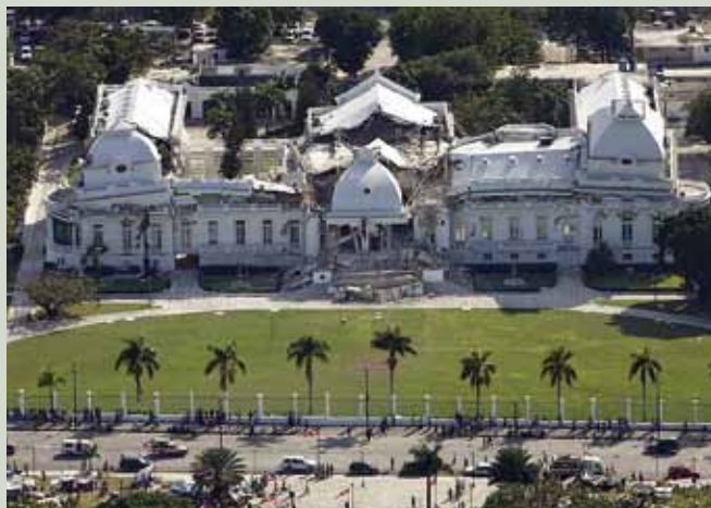
Palácio Presidencial do Haiti atingido pelo terremoto de 2010
